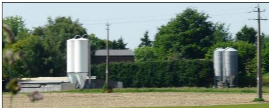
Figure 35 : Photographie de réservoirs, à Longueville
