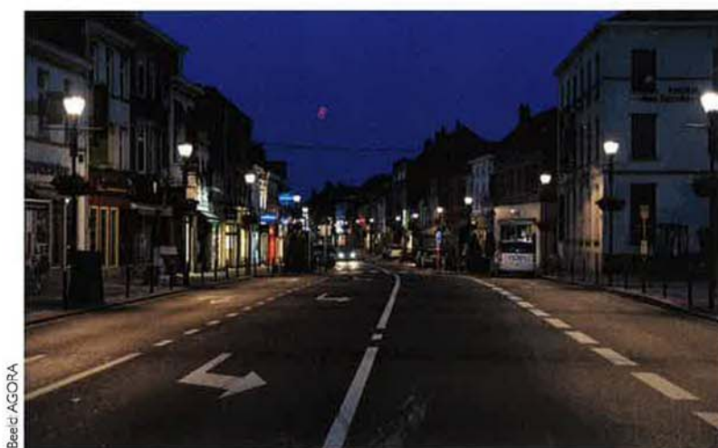
Er is gekozen voor lage lichtmasten van ongeveer 4 m met witlichtelementen en reflectoren, hetzij als console aan de gevel, hetzij als mast.
