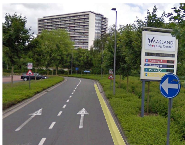
Voirie d'accès avec signalisation dynamique
